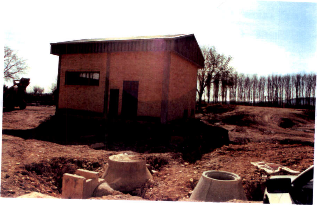
FOTO 1: Caseta de protección del pozo de abastecimiento.
